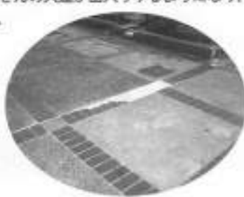
駐車場のガタガタを補修
